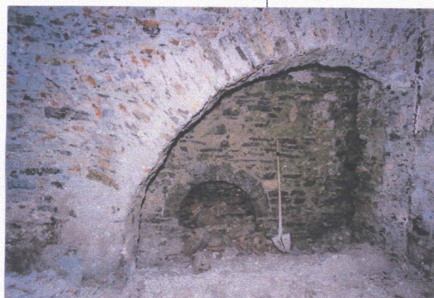
ARCO CON CUNICOLO NEL LOCALE DEL PIANO TERRA
