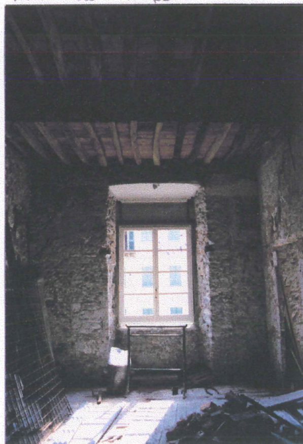
PARTI MEDIOEVALI: LOCALI IN FASE DI RESTAUR.
