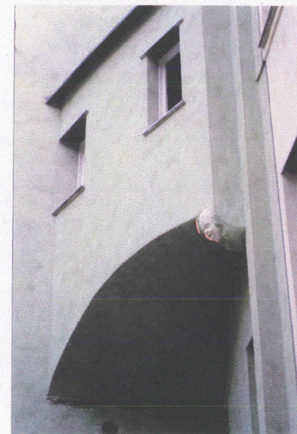
PROSPETTO SU RETRO - PARTICOLARE SUL CORNICE INTERNO.
